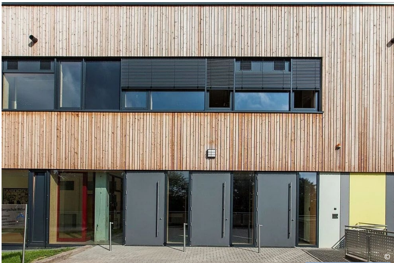
Abbildung 24: Foto der Fassade der Integrierte Gesamtschule/IGS Wollenbergschule in Wetter nach der seriellen Sanierung
